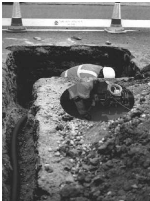
AquaMaster 的直埋式安装
